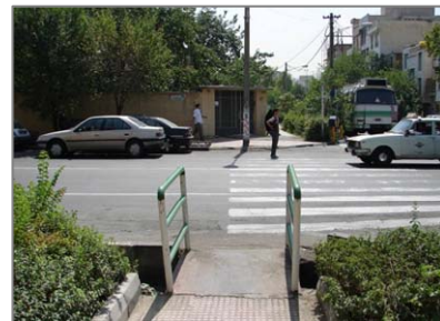
شکل هفت: اجرای خط‌کشی ویژه عابر پیاده در محل نادرست، خیابان دردشت
