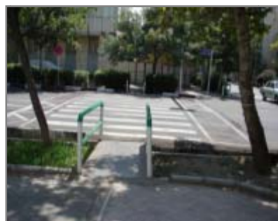
شکل یک: اتصال پیاده‌رو به سواره‌رو توسط پل خیابان مدائن
