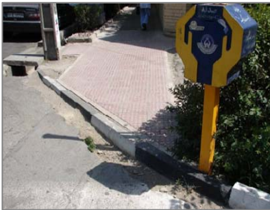
شکل شش: اتصال نامناسب پیاده‌رو به سواره‌رو، خیابان دردشت
