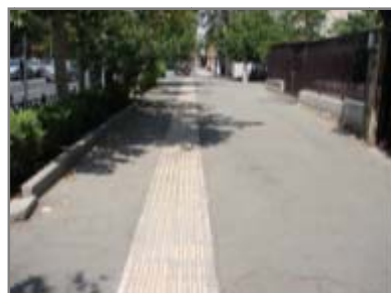
شکل سه: مسیر ویژه تردد نابینایان خیابان گلبرگ
