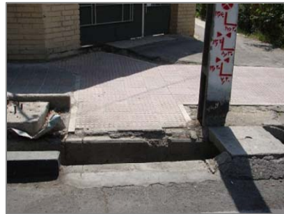
شکل پنج: عدم اتصال پیاده‌رو به سواره‌رو، خیابان دردشت
